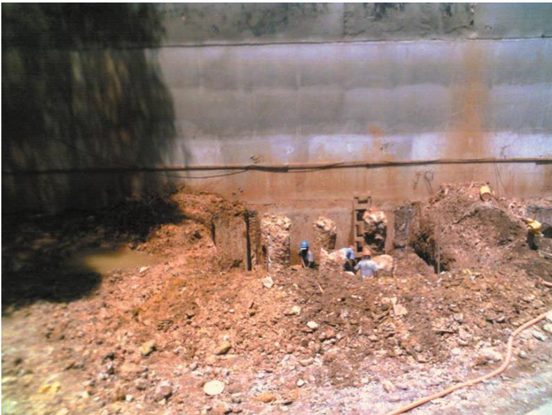
Foto 11: Escavações da obra do Astor, quando já foi observada a presença do lençol freático a (-) 1,80 m da superfície.
